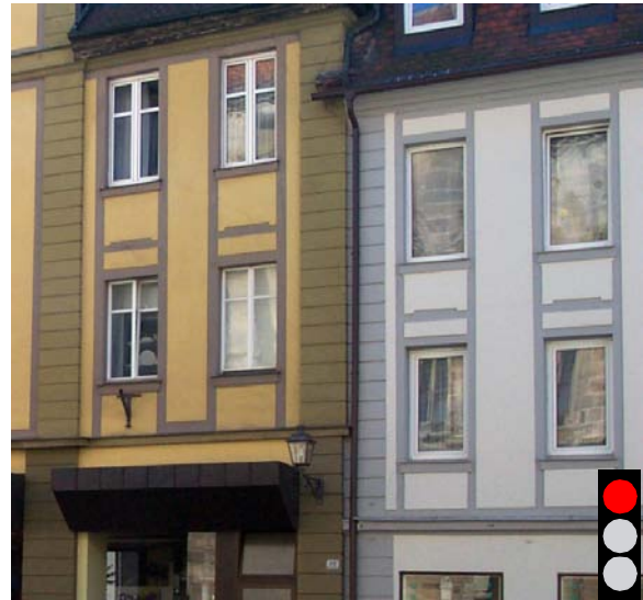
Die ungeteilten Fensterflügel rechts passen nicht zum Charakter eines alten Hauses.
