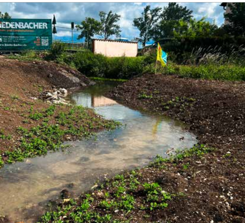
Das frisch angelegte Bachbett des Kühwasengrabens führte am 11. Juni 2026 das erste Wasser auf neuem Wege – bis zur Landesgartenschau und darüber hinaus, Foto: Bayerische Landesgartenschau Bad Windsheim 2027 GmbH.
