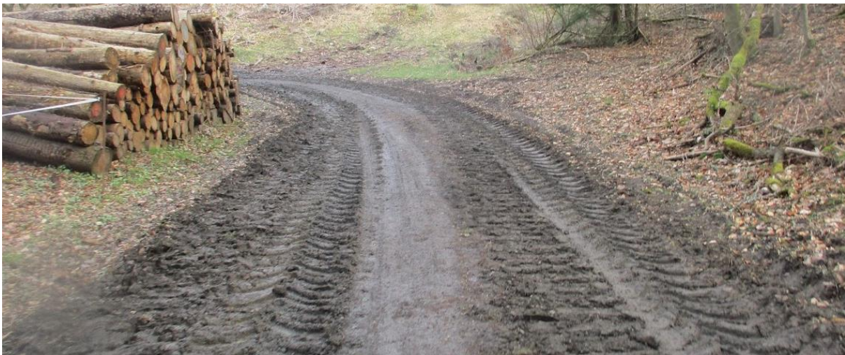
Abbildung 57 – Beispiel einer Radwegeverbindung, die nach Forstarbeiten nur noch eingeschränkt nutzbar ist (eigenes Foto (VAR+, 2021))
